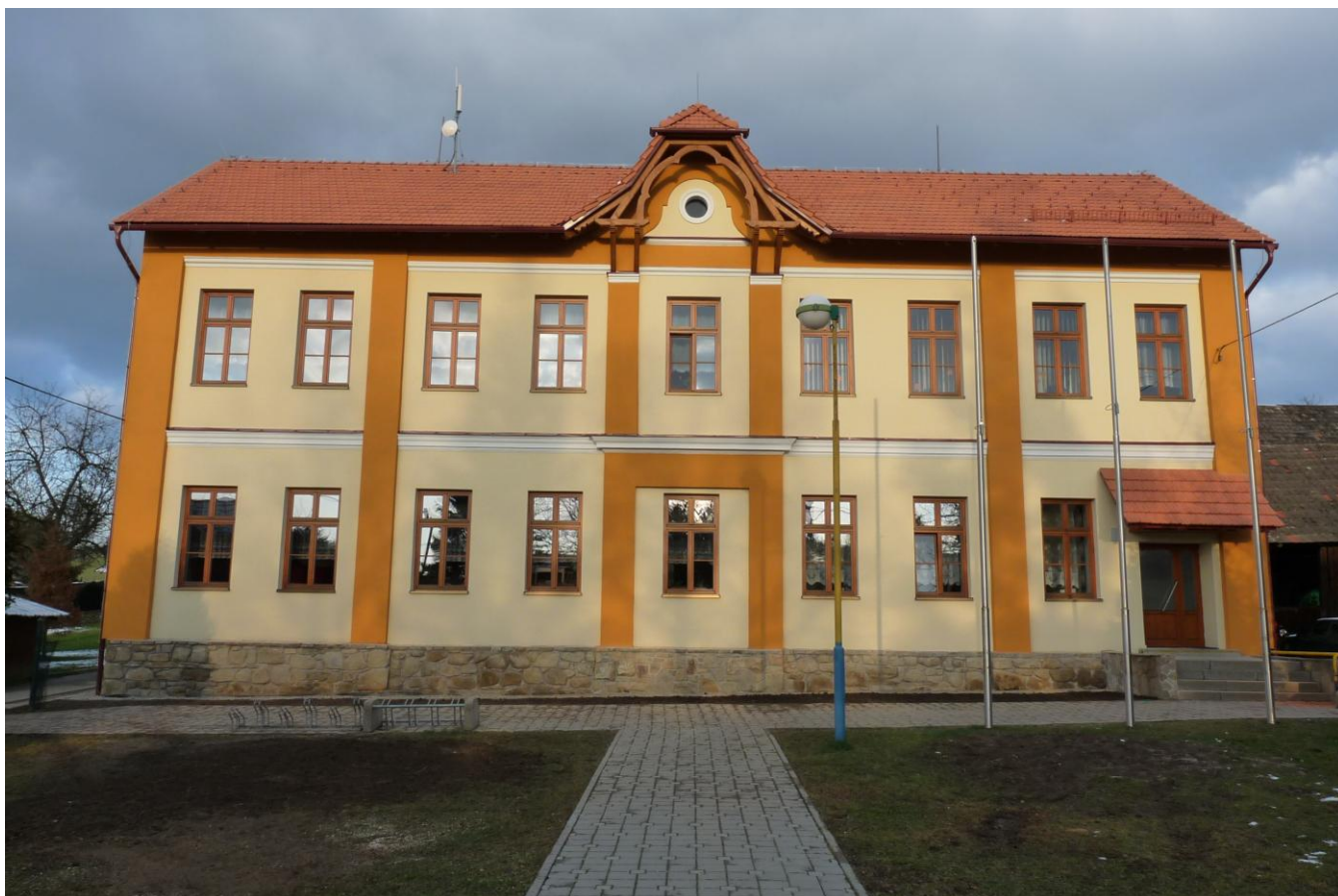
Budova MŠ a OÚ před rekonstrukcí a stav po rekonstrukci
